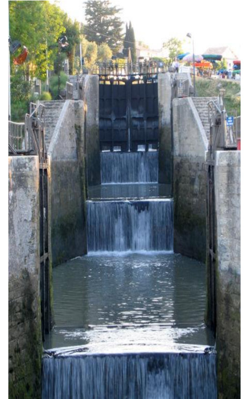
Écluses de Fonseranes à Béziers by Dedounet/Wikimedia Commons/ CC BY-SA 1.0
